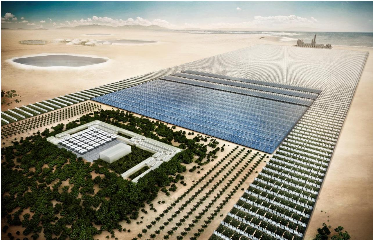
**Arrefecimento evaporativo de estufas**, usando água salgada para cobrir a estufa, permite reduzir temperatura interior em 10°C. (Sahara Forest Project)
